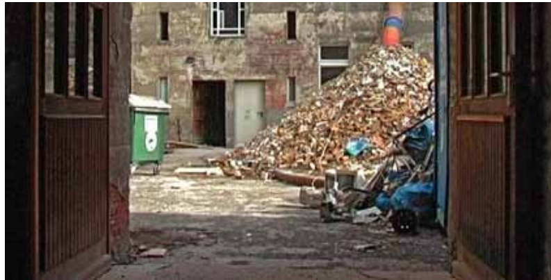
Blick in der Hof der Lychener 64 vor der Sanierung
